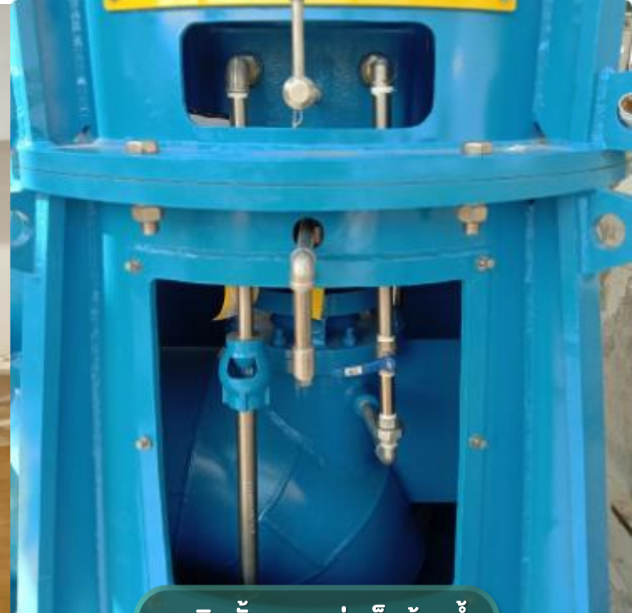
การติดตั้งระบบหล่อเย็นด้วยน้ำ
