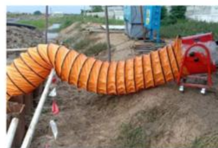
5.2.1 รูปที่ 12 -ติดตั้ง พัดลมดูดอากาศ บ่อดิน/บ่อรับ )
