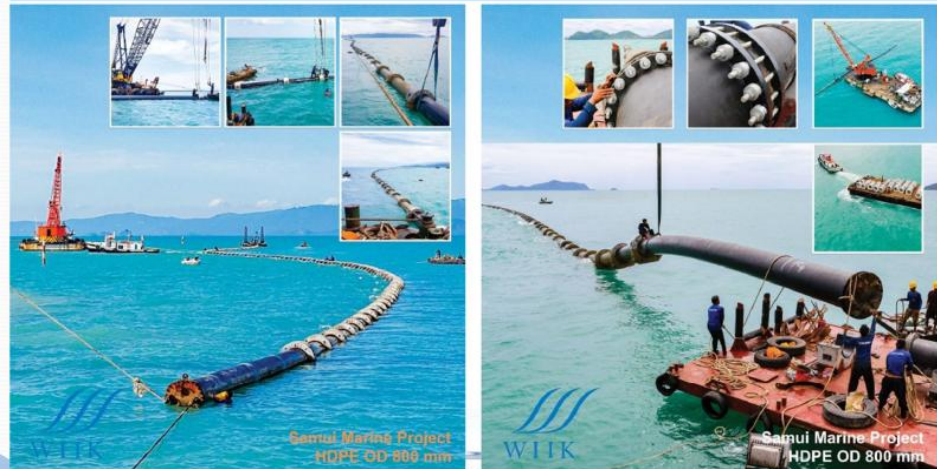
การเชื่อมต่อท่อในทะเลบน Barge -กรณีน้ำลึก < 15 m
