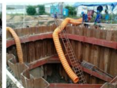
5.2.1 รูปที่ 12 -ติดตั้ง พัดลมดูดอากาศ บ่อดิน/บ่อรับ )
