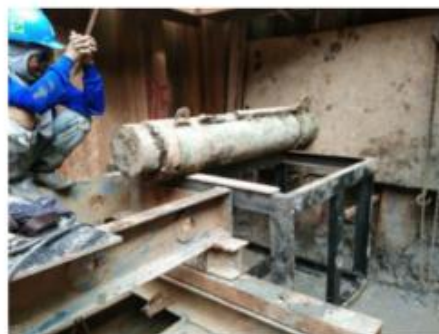
5.2.3 รูปที่ 14 — เช็กระดับและแนวท่อที่จะขุด และติดตั้งรางดิน และอุปกรณ์ (บ่อคั่น)
