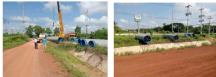
5.3 รูปที่ 16 เริ่ม เตรียมท่อปลอกเหล็กที่จะดิน ขนาดโคใน 1.1 ม.และท่อ 1.3 ม. ขนาด ขวาท่อนละ 6 ม.มาไว้ที่พื้นที่หน้างาน
