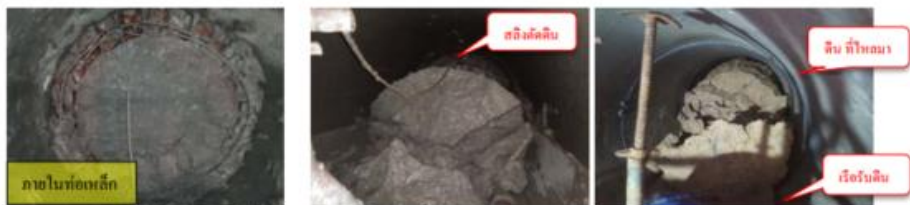
5.3.1.3 รูปที่ 20 และเมื่อดินท่อนไปในดิน ดินจะไหลเข้ามาในเรือบรรทุกดิน จึงทำการตัดดินให้ขาดออกจากกัน แล้วใช้สติงดึง เรือออกมาจากท่อ เพื่อเอาดินที่ได้ ยกขึ้นจากบ่อไปที่จุดทิ้งดิน
