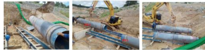
5.3.1 รูปที่ 17 วิธีดินดิน ยกท่อเหล็กลงบ่อด้วยรถ เครม หรือ เบ็คโฮ ยกลงวางบนรางบีม ( น้ำหนัก ท่อนละ 5 และ 7 ตัน
