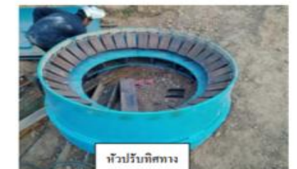
5.2.4 รูปที่ 15 — ติดตั้งชุดกระบอกลดิน และเครื่องั่น ไฮดรอลิก (บ่อคั่น)
