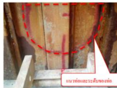
5.2.2 รูปที่ 13 -เช็คระดับและแนวท่อที่จะดัน (บ่อดิน)
