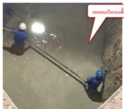
รูปที่ 11 -ติดตั้ง Support ชั้นที่ 2 และ เทคอนกรีตรองพื้น บ่อดิน/บ่อรับ )
