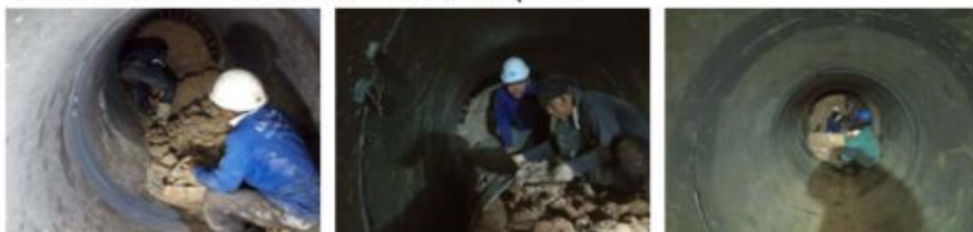
5.3.1.3.1 รูปที่ 21 วิธีใช้แรงงานคนขุดดินขุดดินให้เลยเข้าไปจากหัวท่อ 500 มม.แล้วดันท่อตามเข้าไป และทำการขุดน้ำและดันตามเข้าไปจนถึงเป้าหมายแล้ว ใช้สติงดึง เรือออกมาจากท่อ เพื่อเอาดินที่ได้ ยกขึ้นจากบ่อไปที่จุดทิ้งดิน
