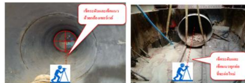
5.3.1.5 รูปที่ 23 เมื่อเอาดินออกหมดแล้ว จึงเช็คแนวเช็คระดับของหัวท่อว่าตรงตามแนวที่กำหนดหรือไม่ เมื่อเช็คเรียบร้อยแล้วไปในแนวที่กำหนดจึง เอาท่อตอนที่ 3 ลงติดตั้ง
