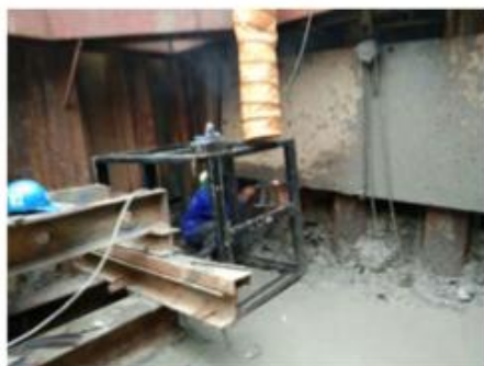
5.2.3 รูปที่ 14 — เช็กระดับและแนวท่อที่จะขุด และติดตั้งรางดิน และอุปกรณ์ (บ่อคั่น)
