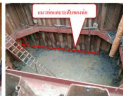
5.2.2 รูปที่ 13 -เช็คระดับและแนวท่อที่จะดัน (บ่อดิน)
