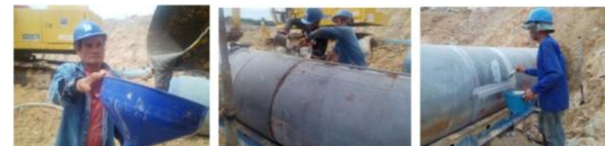
5.3.1.1 รูปที่ 18 ติดตั้งท่อปลอกเหล็กแจ็กกิ้ง ท่อน ที่ 1 และท่อที่ 2 ลงในบ่อดิน และทำการประกอบเข้าด้วยกัน เมื่อ ประกอบเสร็จ จึงทำการเชื่อม ๆ เสร็จทำPT และทาสี ท่อชั้นใน และประกอบ เชื่อม Cover plate เก้าปูน และทาสี
