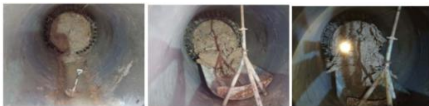
5.3.1.2 รูปที่ 19 เขาเรือบรรทุกดิน เข้าไปไว้ในท่อและใช้สแตนปรับขากันเรือไว้ไม่ให้เรือลอยออกมา
