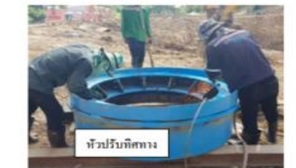
5.2.4 รูปที่ 15 — ติดตั้งชุดกระบอกลดิน และเครื่องั่น ไฮดรอลิก (บ่อคั่น)
