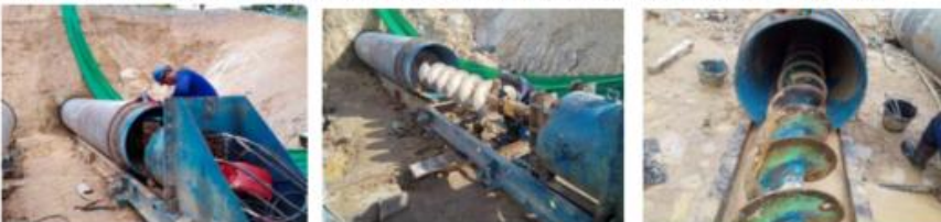
5.3.1.3.1 รูปที่ 21 วิธีใช้แรงงานคนขุดดินขุดดินให้เลยเข้าไปจากหัวท่อ 500 มม.แล้วดันท่อตามเข้าไป และทำการขุดน้ำและดันตามเข้าไปจนถึงเป้าหมายแล้ว ใช้สติงดึง เรือออกมาจากท่อ เพื่อเอาดินที่ได้ ยกขึ้นจากบ่อไปที่จุดทิ้งดิน
