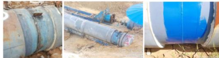
5.3.1 รูปที่ 17 วิธีดินดิน ยกท่อเหล็กลงบ่อด้วยรถ เครม หรือ เบ็คโฮ ยกลงวางบนรางบีม ( น้ำหนัก ท่อนละ 5 และ 7 ตัน
