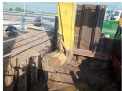
รูปที่ 10 -ติดตั้ง Support ชั้นที่ 1และชั้นที่ 2 บ่อดิน/บ่อรับ )
