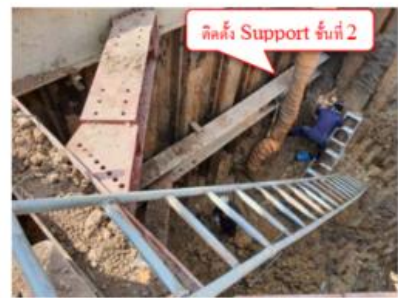
รูปที่ 10 -ติดตั้ง Support ชั้นที่ 1และชั้นที่ 2 บ่อดิน/บ่อรับ )
