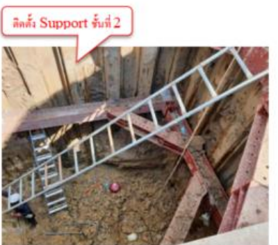
รูปที่ 11 -ติดตั้ง Support ชั้นที่ 2 และ เทคอนกรีตรองพื้น บ่อดิน/บ่อรับ )
